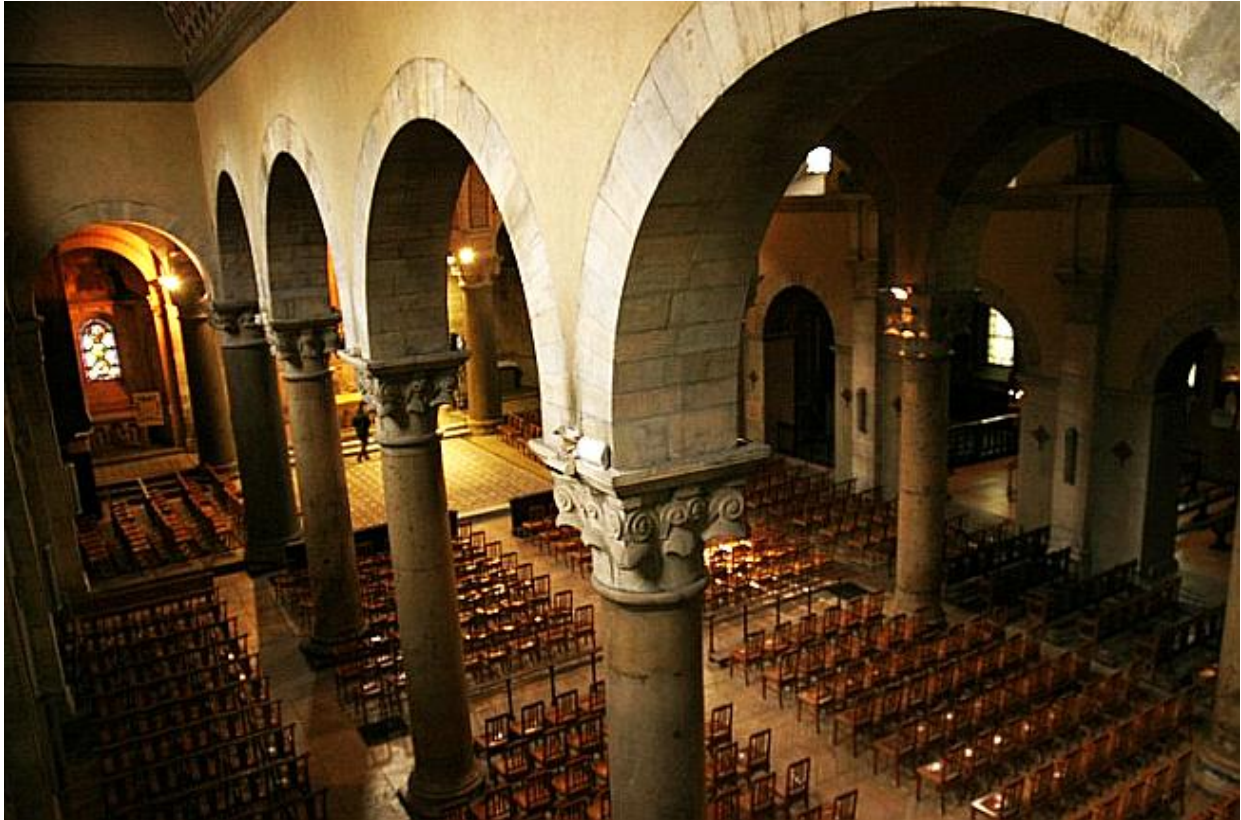
Figure 15 : Colonnade de la nef avec ses chapiteaux corinthiens à feuilles grasses, les colonnes supportant la coupole s'intégrant parfaitement à l'ensemble
